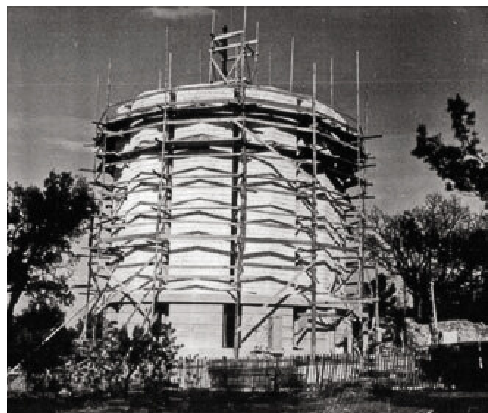
Le château d'eau en construction, 1952-1953 © Espace culturel Pierre Fournel, Ville de Castelnaud-le-Lez.
