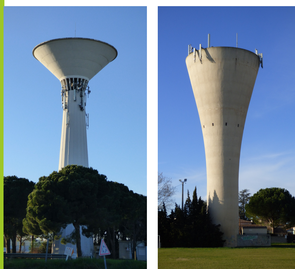
À gauche, le château d'eau de Mauguio, route de Vendargues (1962-1963) et à droite, le château d'eau de Mudaison, rue des Colverts (début 1970) © Espace culturel Pierre Fournel, Ville de Castelnaud-le-Lez.
